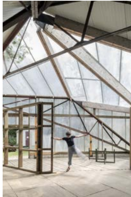
Buitenplaats Brienoord_ 90% Reuse of Materials_ SuperUse
